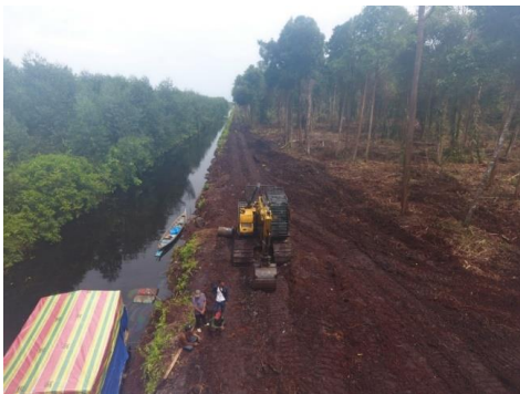
Gambar 25. Terdapat satu unit alat berat milik CV Acoa sedang tidak beroperasi. Berdasarkan informasi dari pekerja alat berat di lapangan, alat berat ini digunakan untuk membuat kanal batas dan menumbang kayu alam. gambar diambil 12 Februari 2024 pada koordinat N 00°00'57.9' E 103°04'52.4"
