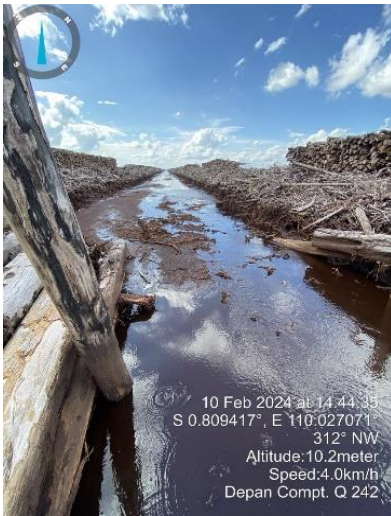
Gambar 90. Kanal yang dibangun bersamaan dengan pembukaan lahan di dalam konsesi, lokasi ini berada di wilayah Prioritas Restorasi Gambut Tidak Berkanal (gambut utuh) dan wilayah fungsi ekosistem gambut budidaya. Gambar diambil 10 Februari 2024 pada koordinat 110,052594; -0,783997.
