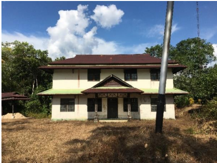
Gambar 87. Camp Finnantara Intiga di dusun Entanjan, desa Empodis, tampak terbengkalai dan tidak ada aktivitas perusahaan. Kantor PT. Finnantara Intiga sekarang telah pindah ke desa Mengkiang. Foto diambil 18 Desember 2023 pada koordinat 110,583028; 0,463831
