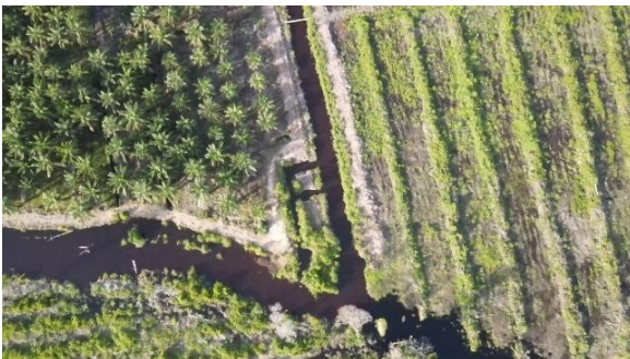
Gambar 42. Pembangunan kanal PT SRL Blok IV Pulau Rupert. Gambar diambil pada titik N1°44'50.54" E101°34'24.47" tanggal 28 November 2023
