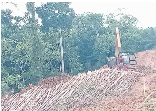
Gambar 129. Alat berat sedang melakukan land clearing dan pemanenan kayu di areal perizinan. Tampak tegakan hutan alam berada di sekitar areal yang sedang dibersihkan.
