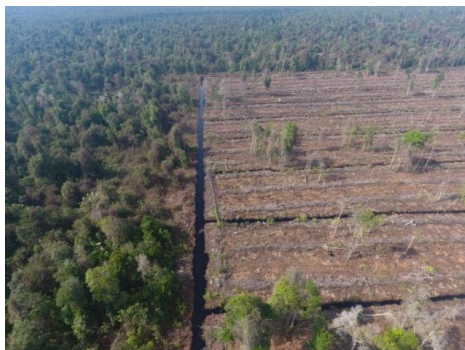
Gambar 35. Kondisi Kanal dan bukaan hutan yang telah ditanami akasia dalam areal Konsesi PT SAU. Gambar diambil pada 20 Maret 2024 dengan koordinat N0°27'32.20" E102°8'23.77"
