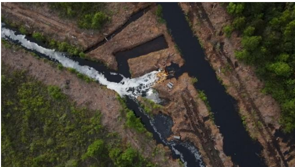
Gambar 38. Kanal PT SRL Rupert. Gambar diambil pada titik N1°45'16.08" E101°35'45.91" tanggal 27 November 2023 menggunakan drone.
