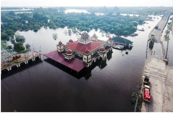
Banjir menggenangi Jalan Lintas Timur km 72-84 serta pemukiman masyarakat di sekitar Jembatan Kerinci
