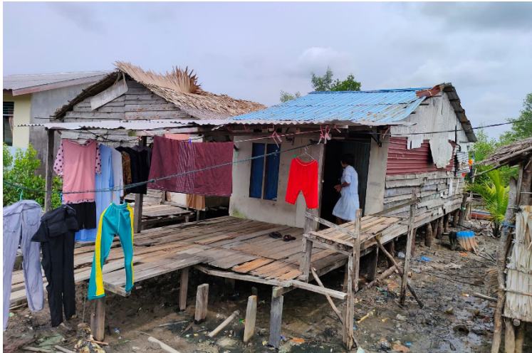
Gambar 5.3 Kondisi Perumahan Penduduk (Sumber: Dokumentasi Pribadi)
